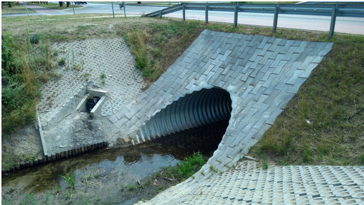
Przykład wykończenia wlotu i wylotu przepustu wielkogabarytowego
