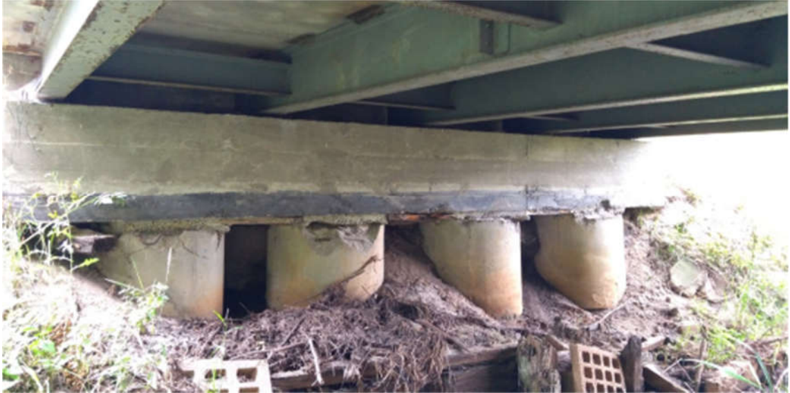
Posadowienie mostu na studniach betonowych
