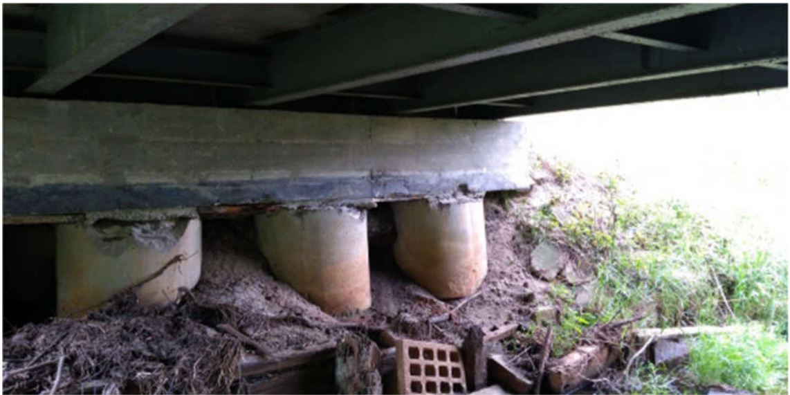
Jak wyżej – degradacja studni fundamentowych
